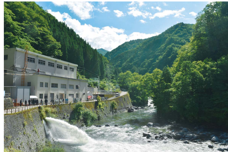
神岡鉱業株式会社 金木戸発電所
